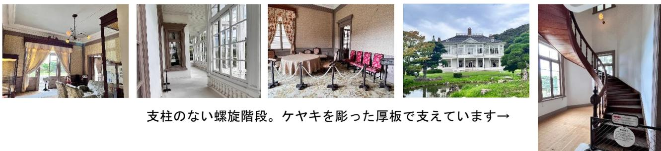
支柱のない螺旋階段。ケヤキを彫った厚板で支えていますー
